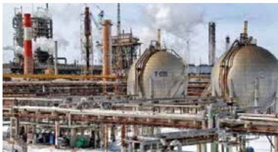
«Тольяттиазот» г. Тольятти. Поставка кабеленесущих систем для электро-снабжения объекта.
