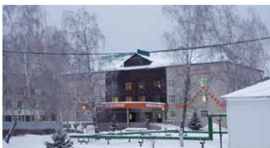
Высокогорская ЦРБ село Высокая гора, РТ. 2хКТПТ-КК-250/10/0,4кВ комплектная трансформаторная подстанция.
